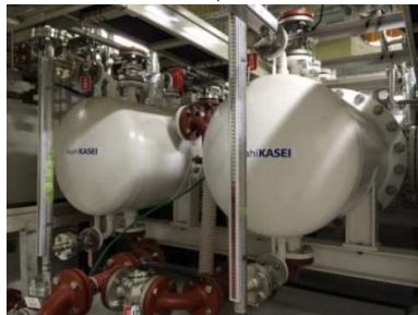
アンモニア合成装置 & 液化アンモニア 貯蔵タンク
