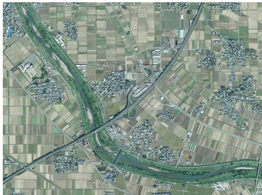
福井インターチェンジ周辺
