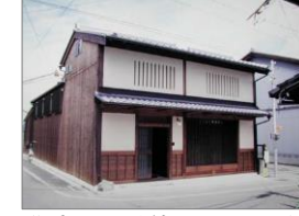
準防火地域等において、伝統的構法の土塗り壁や木造の軒裏の仕様を一般的に利用可能とした
