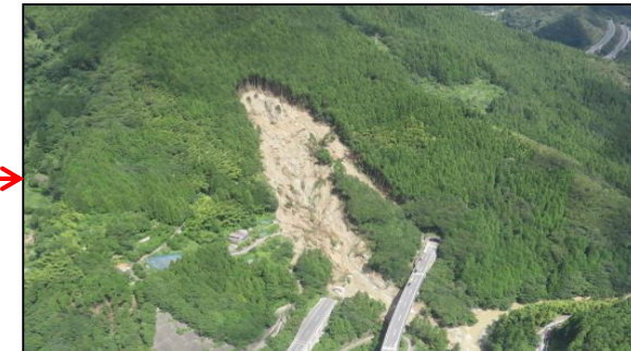
【7月7日 地すべり災害(平成30年7月豪雨災害)】
