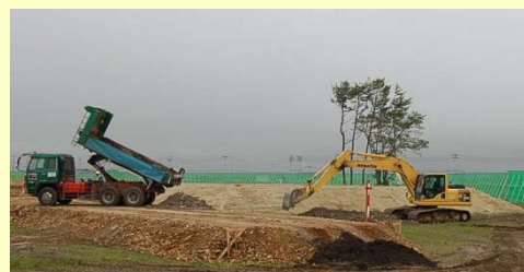
〔生育基盤の整備のための盛土工事〕
