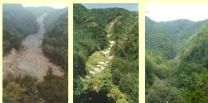
〔 土石流発生箇所における治山事業の実施 〕
