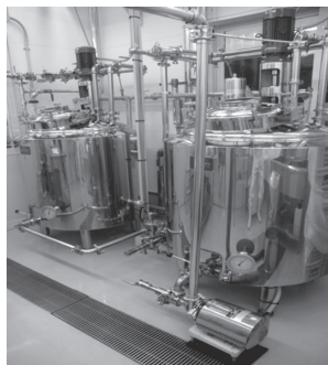
【写真3】自社で設計、建築したミニプラント。
