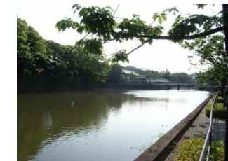
皇居外苑濠水の 貯留・浄化施設
