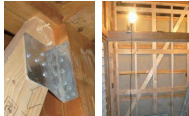
住宅の耐震補強工事
