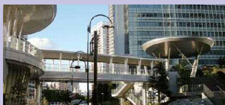
東口第3地区への歩行者デッキ
