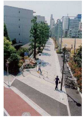
生活道路整備
