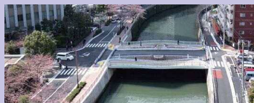
完成した小関橋
