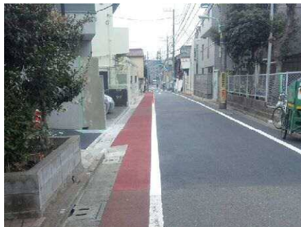
地区防災道路(大原通り)拡幅整備
