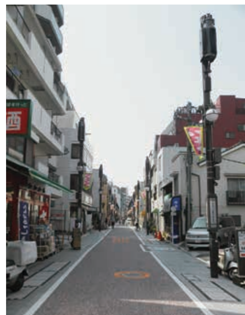
商店街の電線類地中化（北品川地区）
