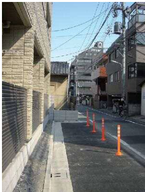
荏原文化センター通り 拡張整備
