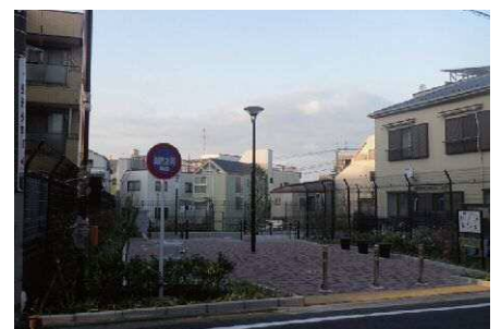
中延みちしるべ防災広場整備
