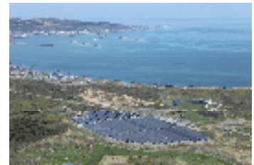
【稚内メガソーラー発電所全景】 ((株) 明電舎提供)
