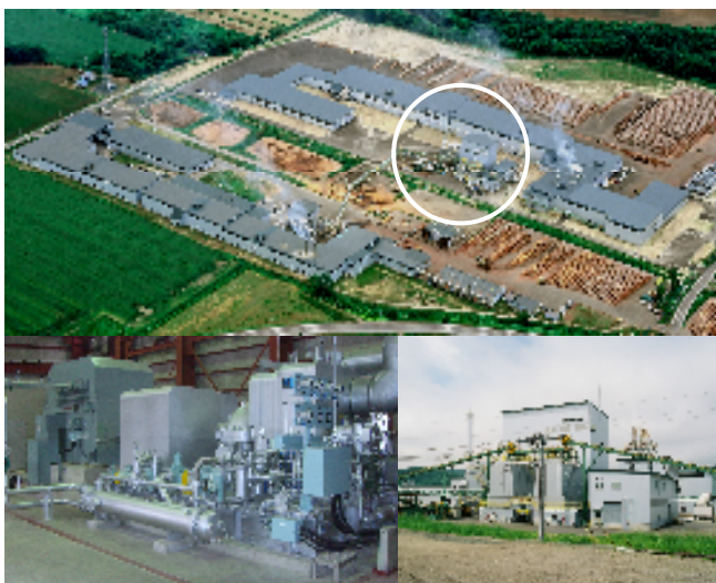
津別単板協同組合（網走郡津別町） 木質バイオマスコージェネレーション施設全景（上） コージェネレーション装置（左下）、ボイラー棟（右下） （写真・津別単板協同組合提供）
