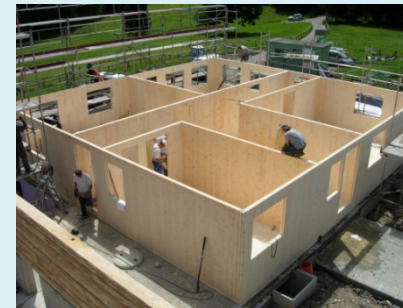
CLTパネル施工状況 (ヨーロッパの事例)
