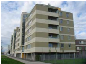
7階建てCLT共同住宅(オーストリア)
