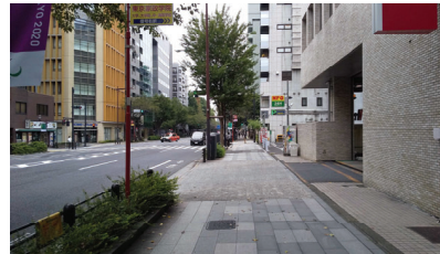
幅が十分に広い歩道
