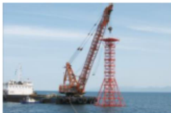
海底地盤調査（うちポーリング調査）の作業イメージ
