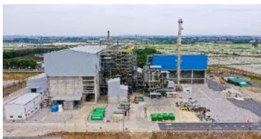
廃棄物発電（ベトナム）
