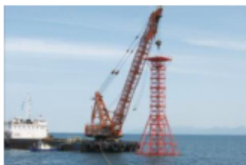
海底地盤調査（うちホーリング調査）の作業イメージ
