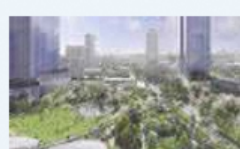
グラングリーン大阪HPより
