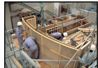
鉄筋コンクリート型枠施工実習
