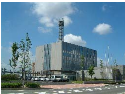
久留米ビジネスプラザビル
