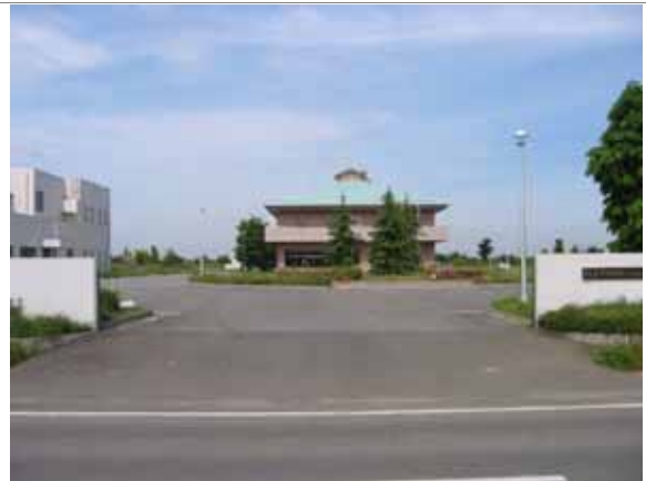
さしまアクアステーション処理場
