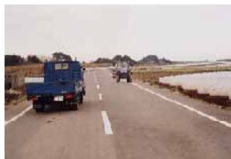
一部供用を開始した広域農道
