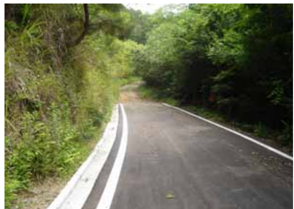
林道の舗装化
