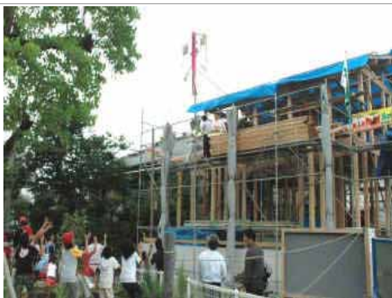
「産直住宅 上棟」
