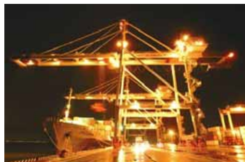
アイランドシティ国際コンテナターミナル
