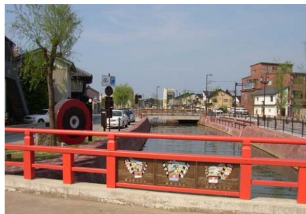
御祓川に架かる仙対橋 （でか山を橋のデザインに盛り込んでいる）
