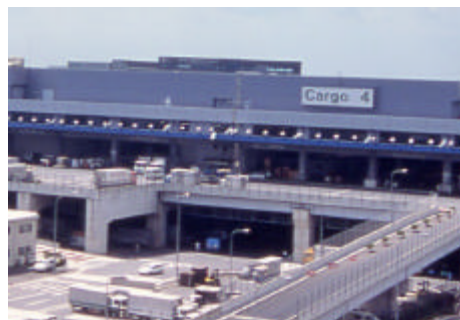
成田空港・貨物ターミナルビル
