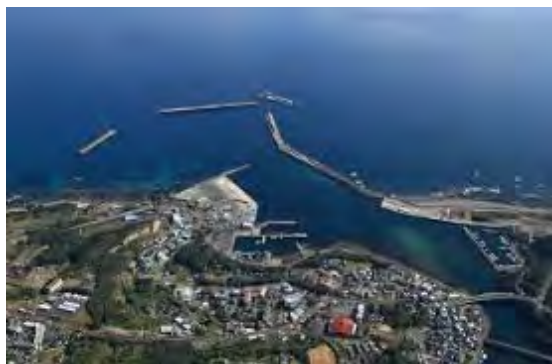
防波堤改良により小型船舶等の安全な接岸、航行を図る安房港
