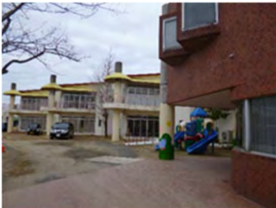
子ども総合支援センター－with の外観
