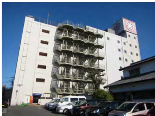
整備を行うビル
