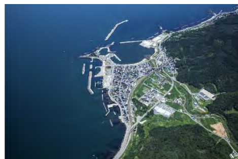
鼠ヶ関港 全体
