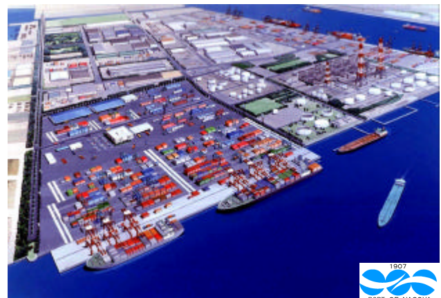
【飛島ふ頭コンテナターミナルと物流基地】
