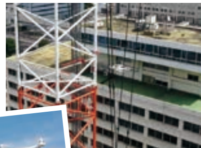
ドローンによる高所設備点検
