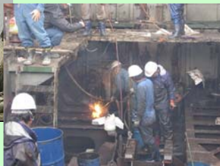
↓船舶の解体作業
