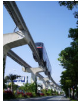
モノレール支柱緑化
