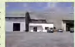
バイオ・エコシステム研究センターの外観
