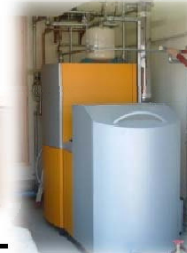
モデル住宅のペレットボイラーによる建築集中暖房システム
