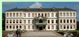
小坂鉱山事務所
