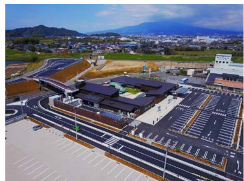
防災拠点としての機能も担う道の駅（函南町）
