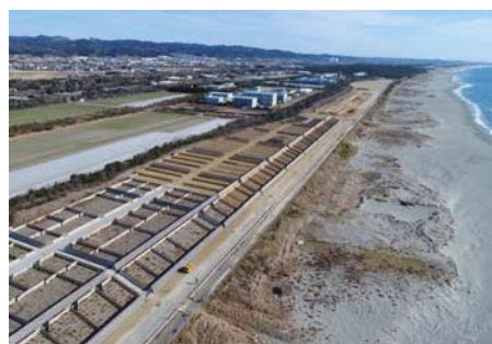
沿岸部の防潮堤の整備（袋井市）
