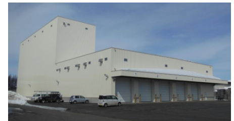
長いも洗浄選別・製品保管施設
