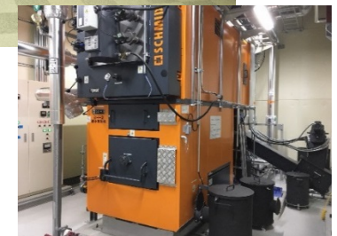
▲木質チップボイラーの設置
