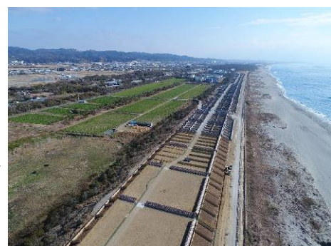
沿岸部の防潮堤の整備（袋井市）
