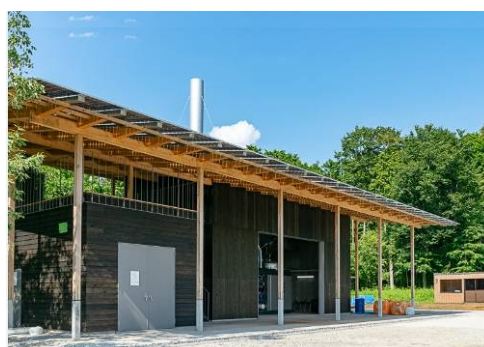
完成した木質バイオマス発電所（小山町）
