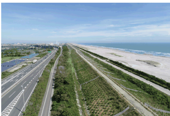
雄大な遠州灘の景観に配慮した津波防潮堤（浜松市）
