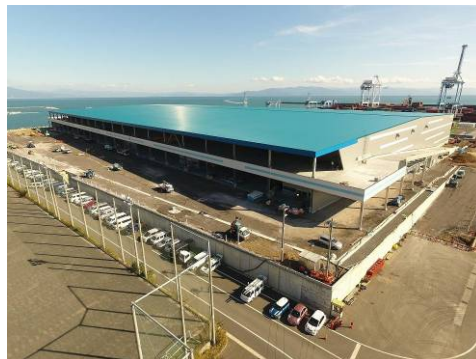
【静岡市】新興津国際物流センター
