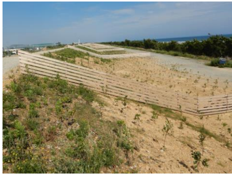
地域住民との連携により植栽が完了した防潮堤（浜松市）
