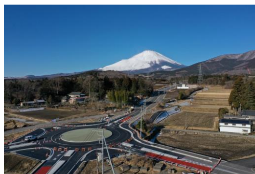
停電時にも円滑な通行が可能なラウンドアバウト型交差点 (小山町)
