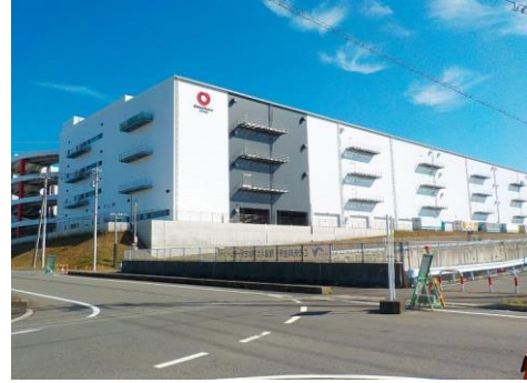
有事にも大きな役割が期待される 県内最大の物流施設（富士市）
