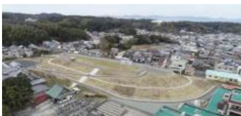
急傾斜地の切土工事による津波避難場所の整備 (湖西市 上田町地区)
