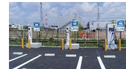
ハイパーエネルギー ステーションB (太陽光+蓄電+V2H充電器)
