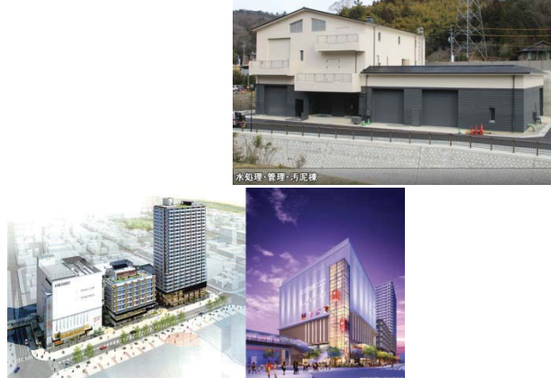
下水熱利用空調システム導入施設
