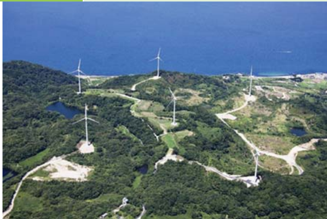
島北部の風力発電施設
