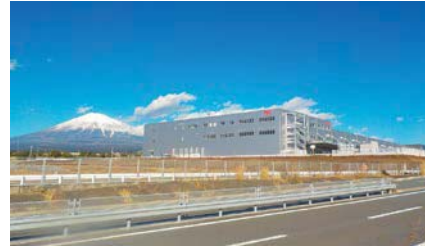
新東名新富士IC周辺における広域的な拠点となる物流施設（平成29年2月稼動：富士市）
