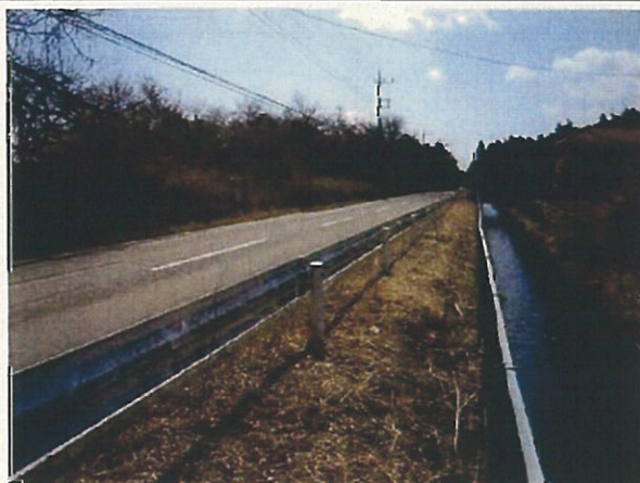
下流方向の状況 (B=5.5m)
