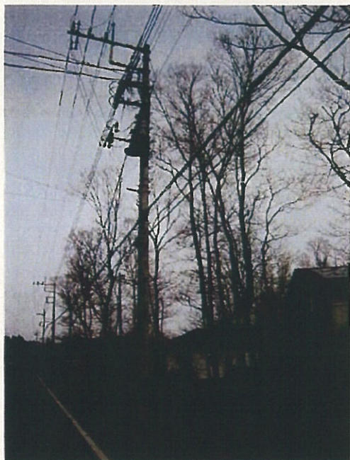
近傍の電柱全景
