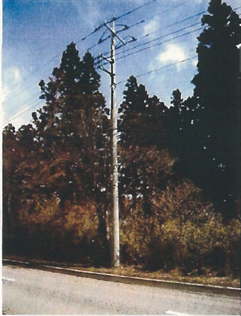
近傍の電柱全景
