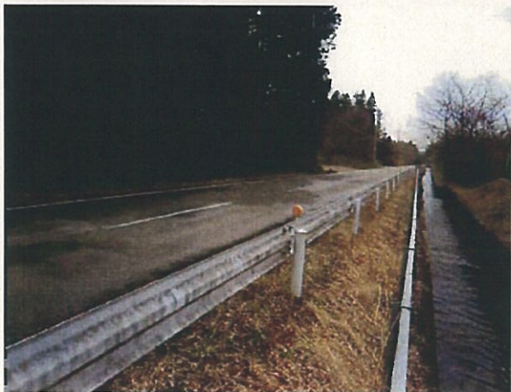
下流方向の状況 (B=5.5m)
