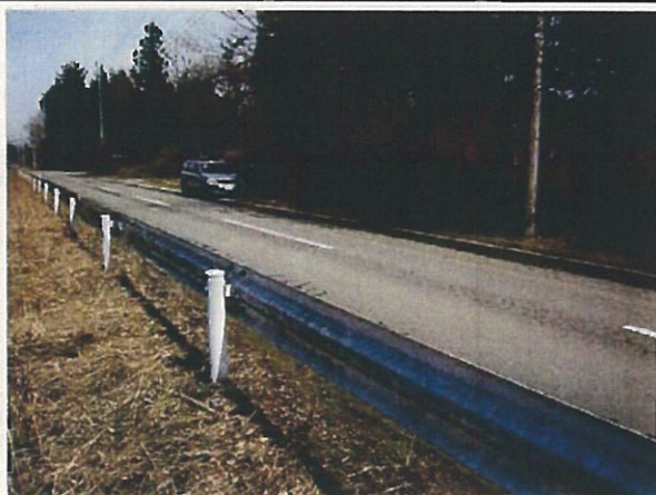
上流方向の状況 (B=5.5m)
