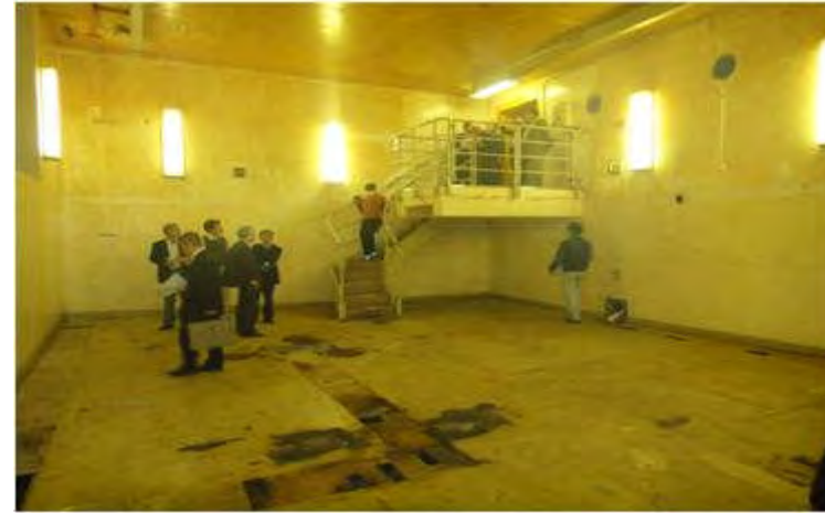
中性子照射室予定室(改修整備前)
