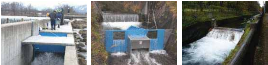
図表5 設置を予定している低落差型小水力発電施設の設置例(先駆性①) (写真左・中央:シーベルインターナショナル製、右:中川水力製)
