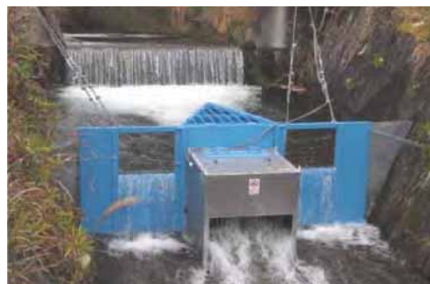
図表③-23 発電システム設置例 2 (栃木県内農業用排水路、定格 1kW)
