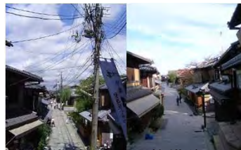
整備前 整備後
