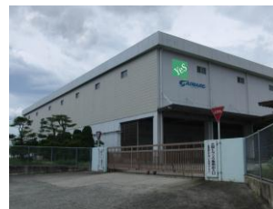
(株)ナノオプトニクス・エナジー 米子工場
