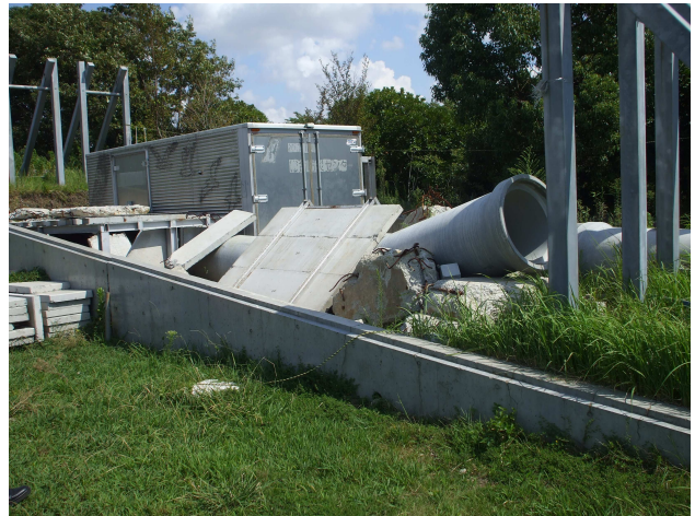
県総合防災センター・消防学校 防災サーキット
