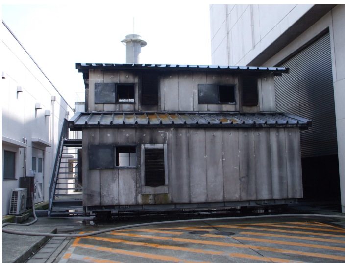
県総合防災センター・消防学校 防災燃焼試験施設
